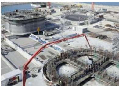
1. Exemple de construction sur quai : Tanger Med, Bouygues ©Tous droits réservés
