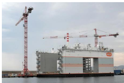
4. Autre type de barge flottante : un caissonier de construction utilisé par Bouygues Travaux Publics pour la construction de la digue de Monaco ©Tous droits réservés
