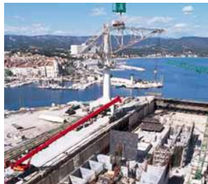
2. Exemple de construction en cale sèche : digue flottante du port de la Condamine, Bouygues ©Tous droits réservés
