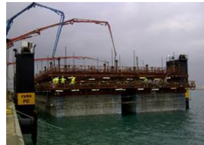
3. Exemple de construction sur une barge flottante en Espagne, CYES travaux maritimes ©Tous droits réservés
