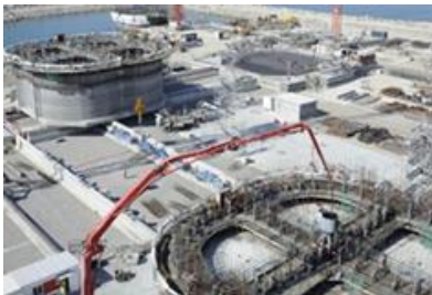
1. Exemple de construction sur quai : Tanger Med, Bouygues ©Tous droits réservés
