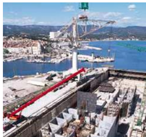
2. Exemple de construction en cale sèche : digue flottante du port de la Condamine, Bouygues ©Tous droits réservés
